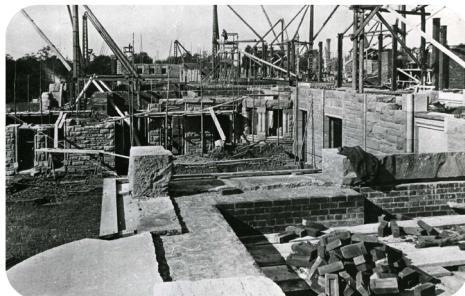
Construction des murs intérieurs et extérieurs en 1887. Il a fallu plus de 10 millions de briques rouges pour ériger les murs intérieurs.
