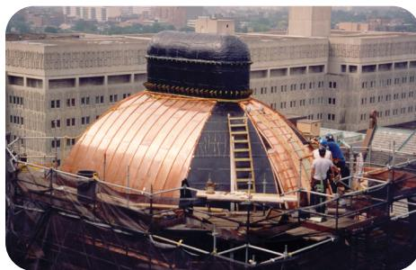
Installation d'un toit de cuivre dans les années 1990. Plus de 51 tonnes de cuivre ont été utilisées dans le revêtement extérieur de l'édifice.
